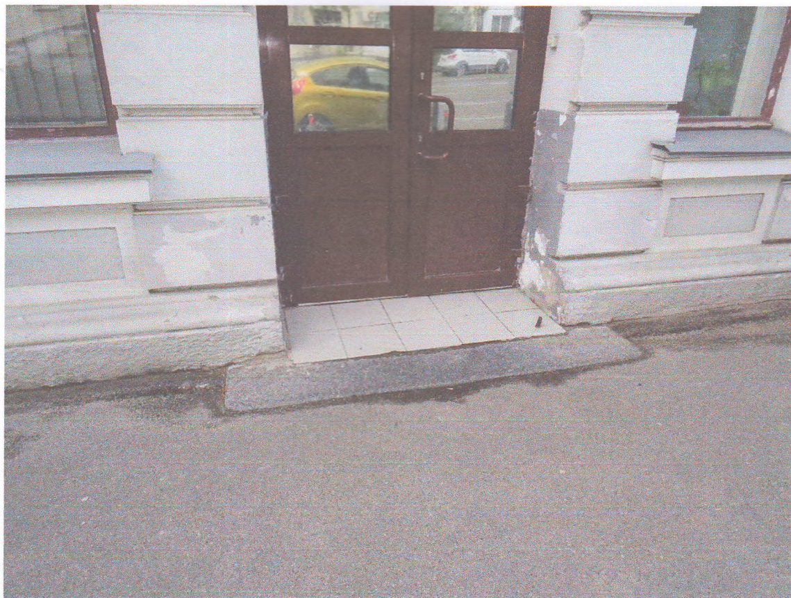
Рисунок 1 Вхід в будівлю
